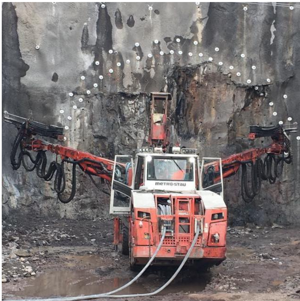
Upphaf framkvæmda við Dýrafjarðargöng
