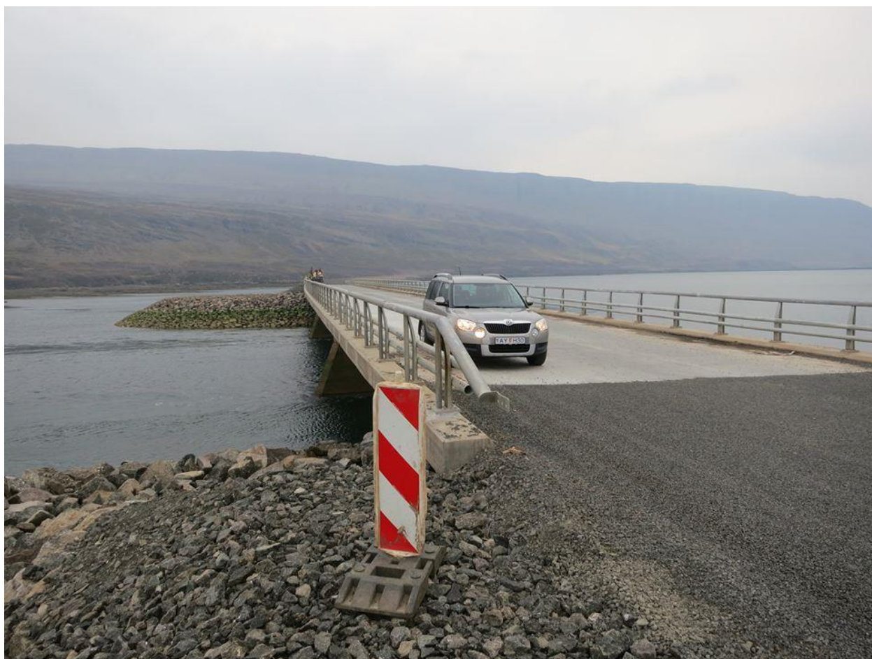
Nýr vegur og brú í Kjálkafirði yfir í Múlasveit í Reykhólahreppi. Mynd Eggert Stefánsson
